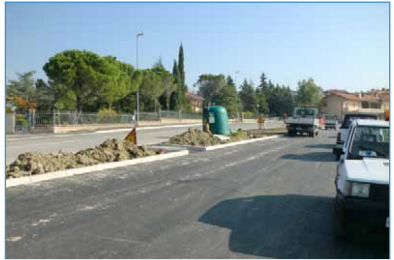
Il parcheggio in costruzione a Monte Pulito
